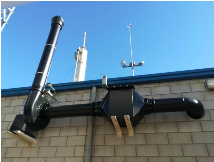
Modul AP Filtre cu carbon activ
